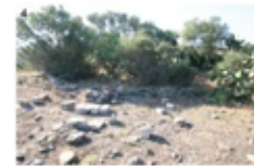
Photo N°2: La bretelle de piste vers la droite est à condamner et cicatiser. - Décompactage très soigné des sols tassés - Mise en scène de blocs rocheux naturels en affleurement (au 2/3 enterrés)
