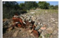
Photos N°5 et N°6: Nettoyage et purge du talus. - Concassage fin des gravats (briques, blocs béton, etc.) - Élimination des déchets métalliques (fers à béton, carcasses et châssis de véhicules, etc.)
